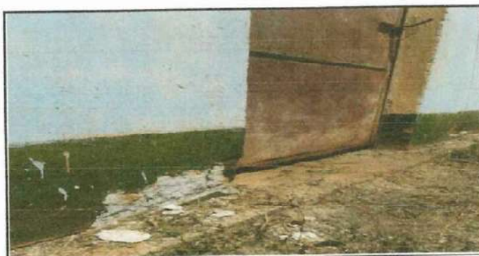
Foto 6: Se observa deterioro de puertas de aulas, sustitución completa.
