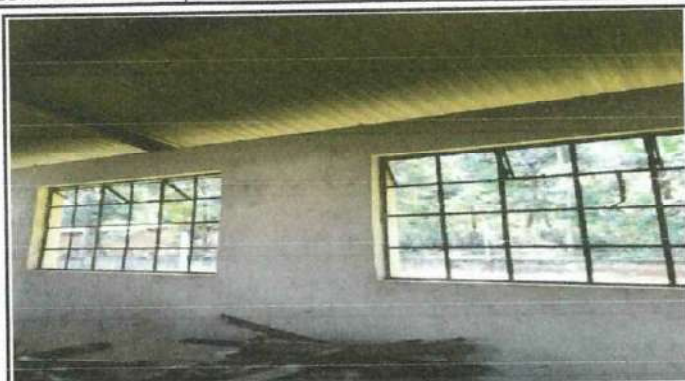
Foto1: Sustitución de láminas troqueladas para 3 aulas
