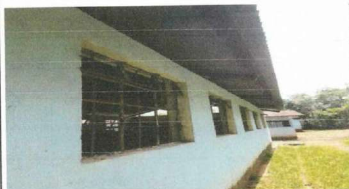
Foto 3: Sustitución de balcones deteriorados para 3 aulas
